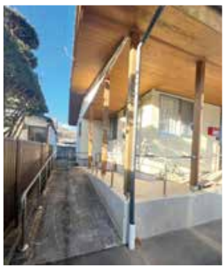
改修時に付けられたスロープ
